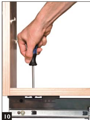
10 Frontblende durch Verdrehen der Neigungsverstellung justieren.
