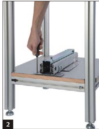
2 Montage der unteren Führung innen auf den Korpusboden. Alle Befestigungspositionen verwenden.
