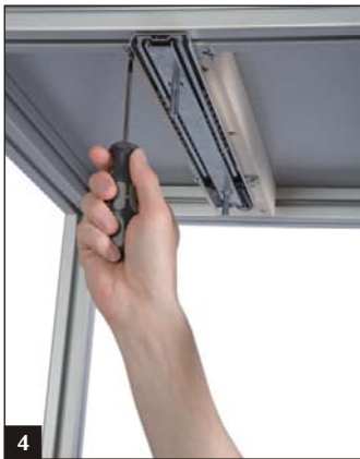
4 Montage der oberen Führung innen an die Korpusplatte.
